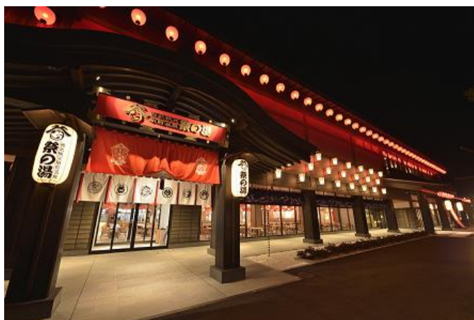
西武秩父駅前温泉 祭の湯 外観
